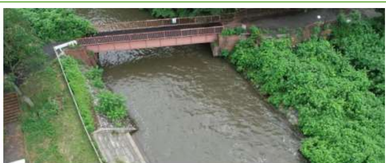
びぜんきょうよてつきょう 備前渠鉄橋 (深谷市上敷免地内)
