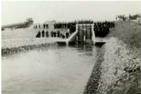
第3樋門 改築工事記録写真 1919年(本庄市久々宇地内) 「煉瓦造りの水門をコンクリート構造物に改築」
